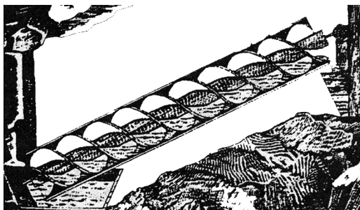
Архимедов винт, позволявший качать воду снизу вверх
