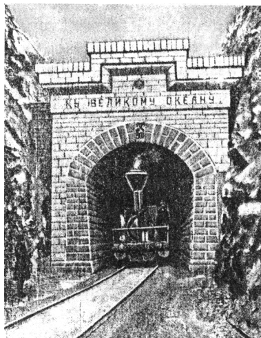
Вход в тоннель, проложенный через Яблоновый хребт
