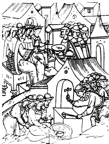
Работы на денежном дворе
